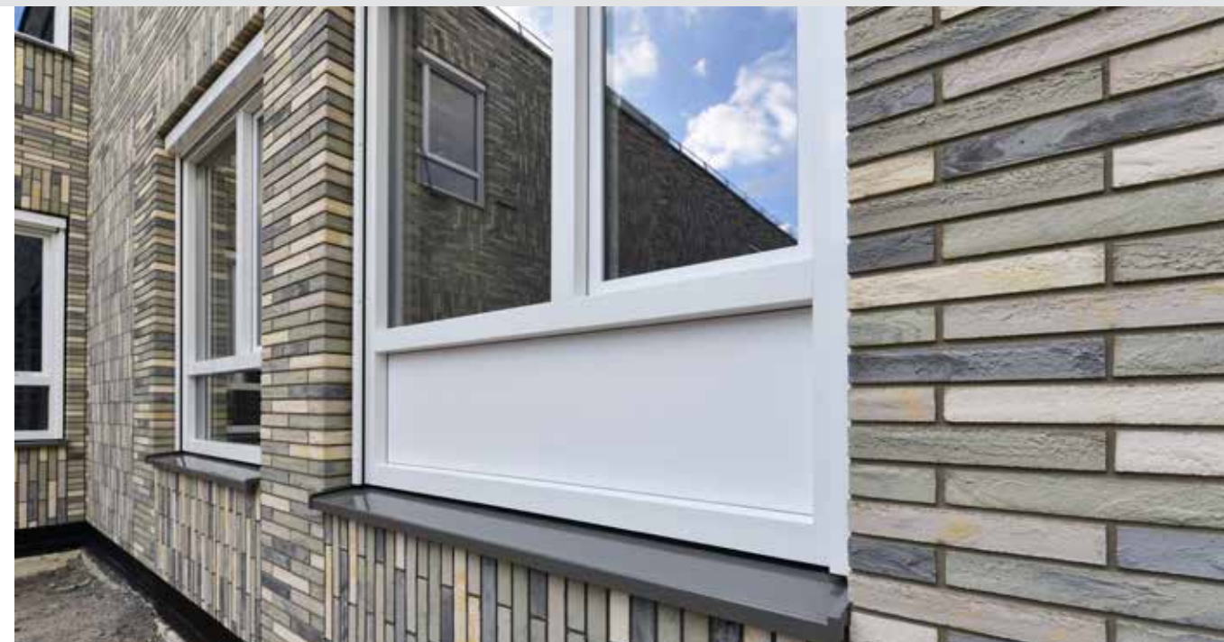
In het scholencomplex zijn 30 circulaire kozijnen ingepast.
