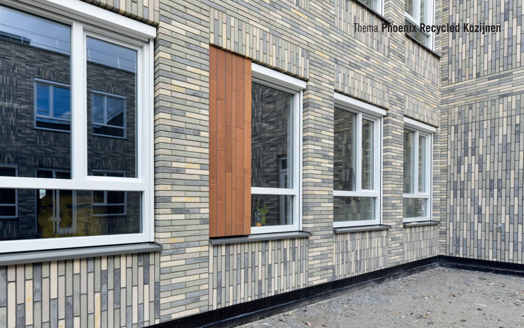
De circulaire kunststof kozijnen werden ook gebruikt in de Avignonschool in Eindhoven.
