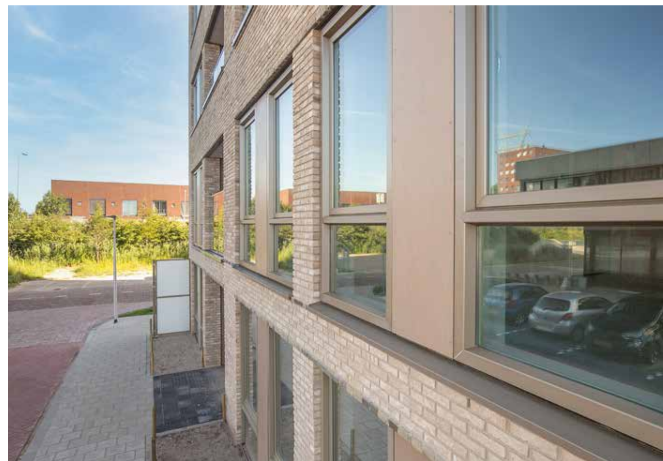
De kozijnen maken integraal onderdeel uit van de prefab gevelelementen.
